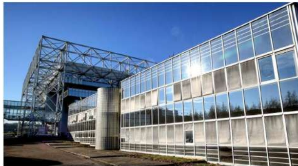
Le centre d'affaires Cescom, dessiné par l'architecte Albert Longo sur le Technopôle de Metz, est le symbole du Parc d'activités créé il y a quarante ans par Jean-Marie Rausch.
